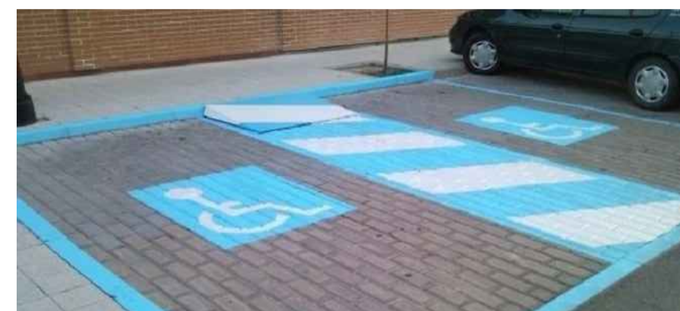
RAMPA EN APARCAMIENTO MINUSVALIDOS
